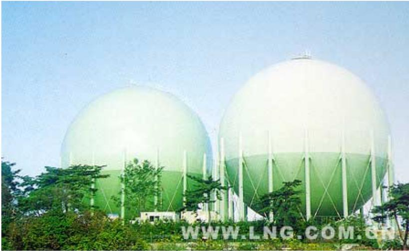
固定式LNG储罐-球形
